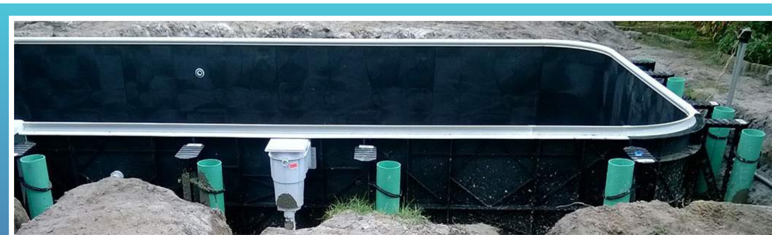
SONO TUBES PLACED AROUND POOL
